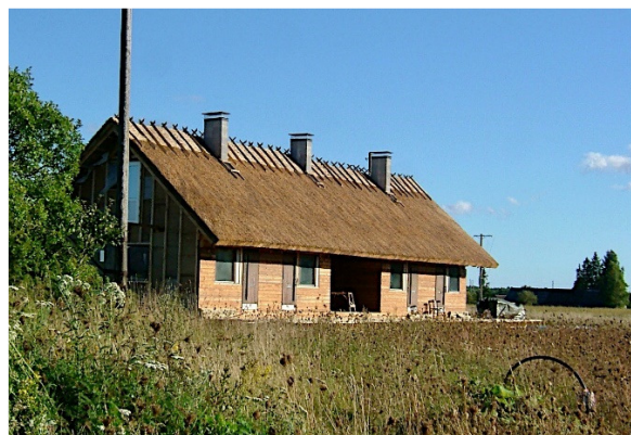
Rivitalon katto valmiina, rakennus on kuin valtamerilaiva kolmine tandemhormeineen.
